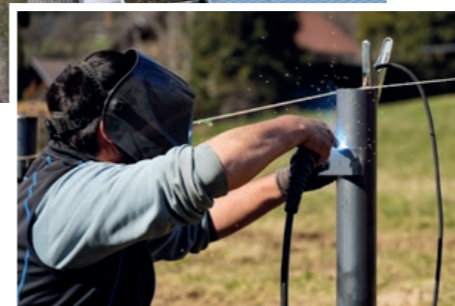
▲ Die Gemeindearbeiter haben dem Spielplatz ein neues Erscheinungsbild gegeben.
